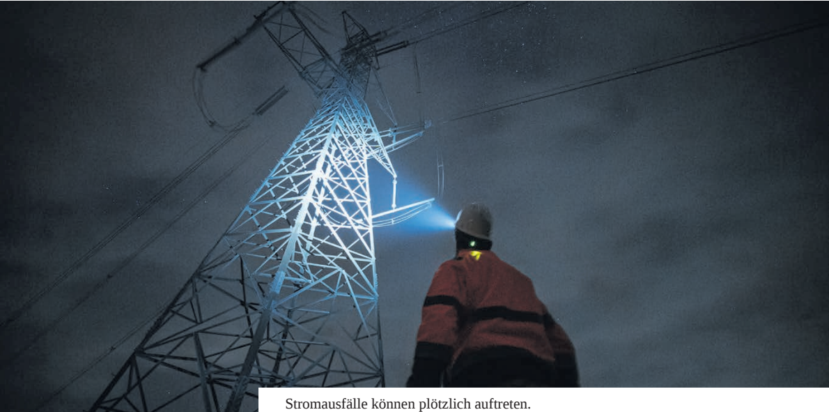
Stromausfälle können plötzlich auftreten.
